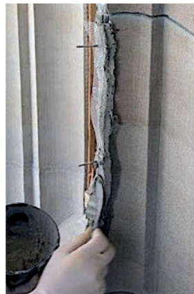
Reparatur einer abgeblätterten Stelle Mittels Netzen und Mörtel.
