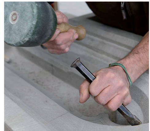
Herstellung eines neuen Steins als Ersatz durch einen Steinmetz mit traditionellem Werkzeug.
