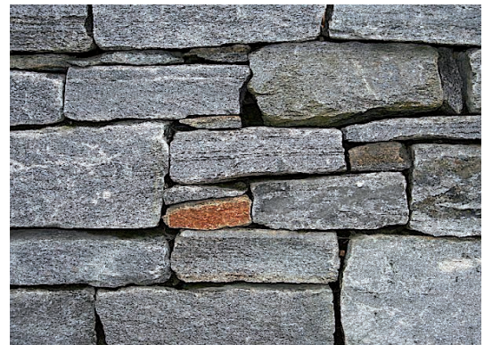
Mauer aus Gneis ohne Zement (Trockenmauer).
