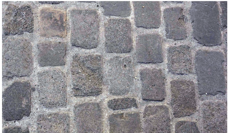
Pflastersteinbelag aus Guberstein in der Postgasse. Beachte, dass die Sandsteine unterschiedlich grobkörnig sind.
