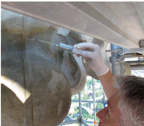
Injektion einer Flüssigkeit, welche in den Rissen aushärtet und den beschädigten Stein stabilisiert. Dafür wird eine medizinische Spritze verwendet.
