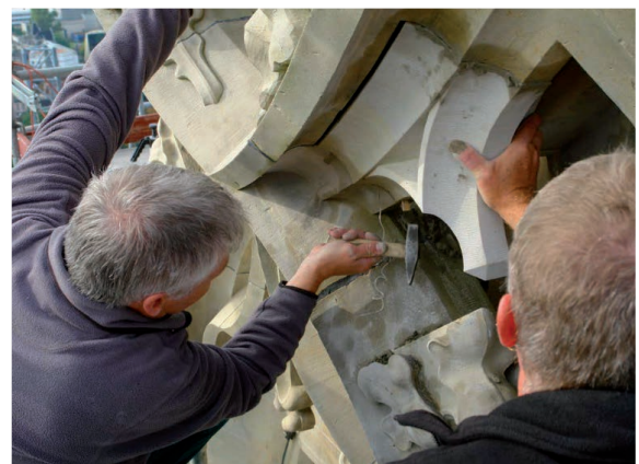
Ein neu hergestellter Stein wird anstelle eines kaputten Steins eingesetzt.
