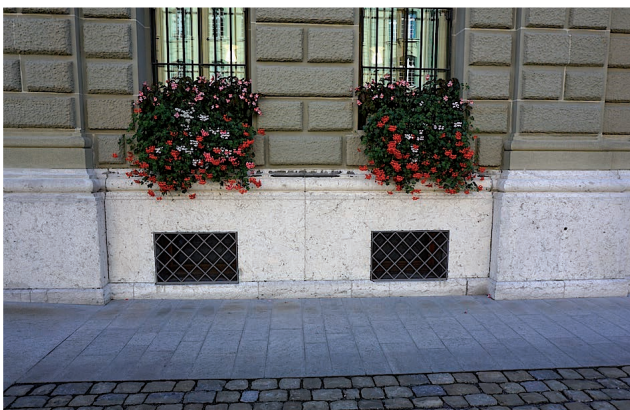
Sockel aus Solothurner Kalkstein unten und Fassade aus Berner Sandstein (siehe Posten 5) oben am Bundeshaus Ost.
