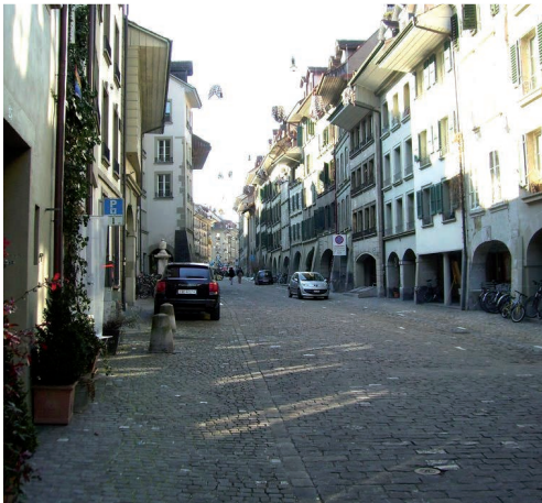
Pflastersteinbelag aus Guberstein in der Postgasse. Beachte, dass die Sandsteine unterschiedlich grobkörnig sind.
