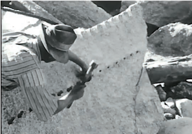
Die Granitblöcke wurden von Hand mit Hammer und Keilen gespalten.
