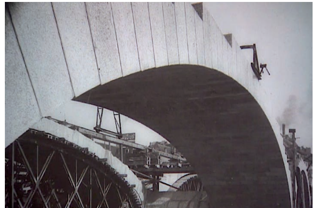
Bau der Bögen der Mittleren Rheinbrücke aus Granit.
