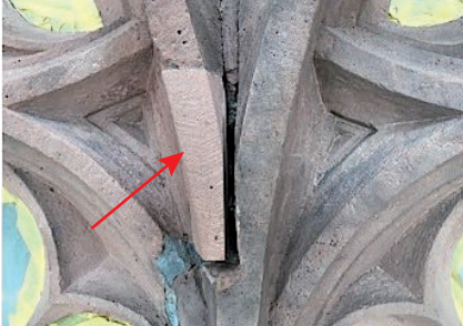
Einsetzen eines neu hergestellten Ersatzsteins (Pfeil).
