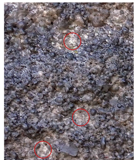
Belag auf den Steinen der Martinskirche. Spuren von Hammerschlägen sind rot markiert
