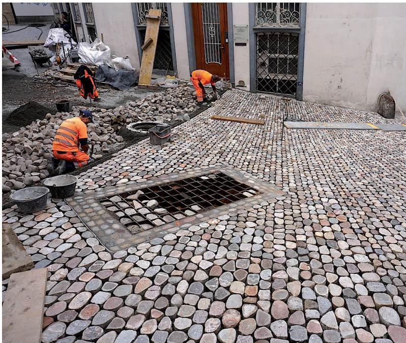
Verlegen von Gwäggi am Schlüsselberg im November 2018.
