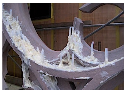
Durch aufgeklebte Röhrchen wird ein flüssiger Kunststoff in Spalten gegossen, der aushärtet und den Stein von Innen stabilisiert.
