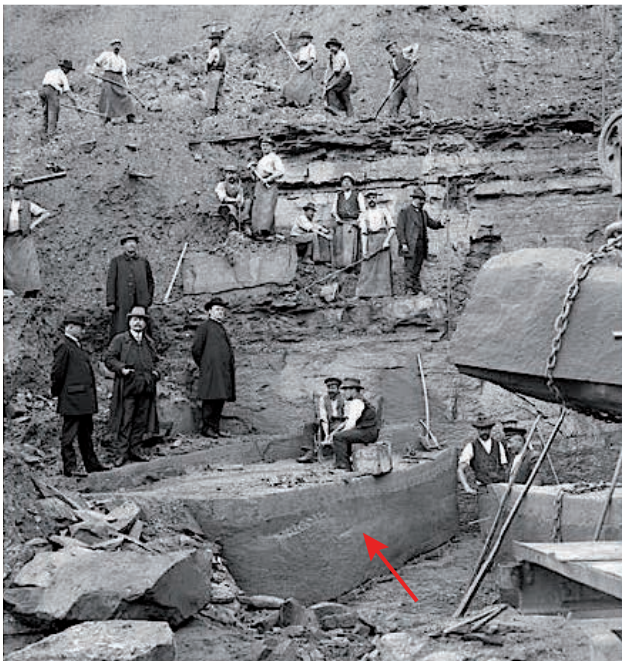
Abbau von Sandstein mit Hammer und Keilen Anfang des 20. Jahrhunderts in der Region von Freiburg. i.Br. Die Schicht mit nutzbaren Steinen ist nur etwa 1.5 m dick (Pfeil), wird aber von ca. 8 m unnützen Gesteins überlagert, das entfernt werden muss.
