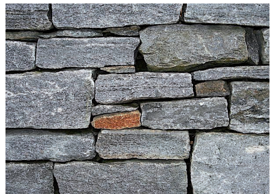
Mauer aus Gneis ohne Zement (Trockenmauer).
