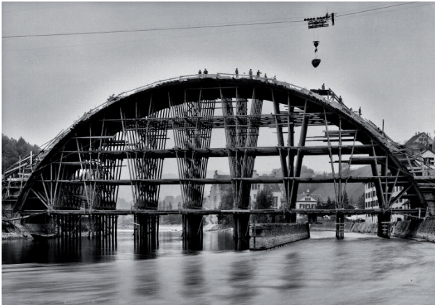
Der grosse Brückenbogen wird über dem Lehrgerüst betoniert. Der Beton wird mit einer Seilbahn hinzutransportiert (Schweiz. Bauzeitung).
