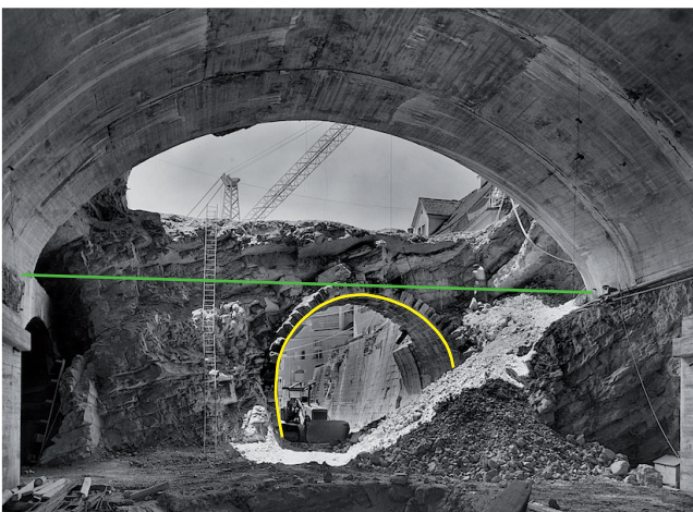
Ausbruch des neuen Autotunnels durch den Schlossberg mit Resten des alten Bahntunnels (gelb), Blick Richtung Schulhausplatz. Die Fahrbahn des Strassentunnels kommt auf die Höhe der grünen Linie zu liegen (Stadtarchiv Baden). Darunter befinden sich das Parkhaus Tunnelgarage und ab 2018 Teile des neuen Bustunnels.
