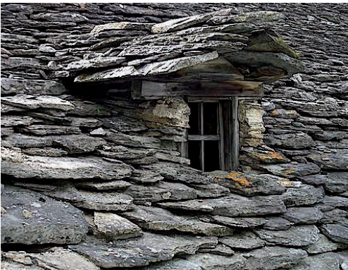
Abb. 8: Altes Dach aus Gneis
