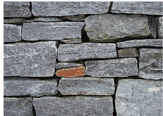
Abb. 5: Mauer aus Gneis ohne Zement (Trockenmauer)
