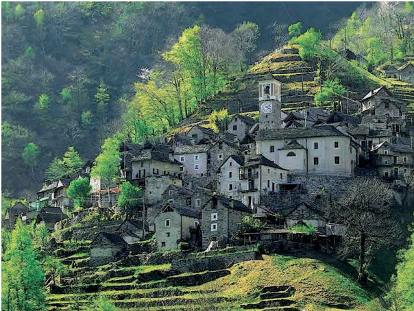
Abb. 6: Die Dächer in Corippo in der Valle Verzasca (Tessin) sind mit Gneisplatten gedeckt
