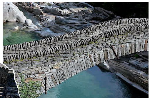
Abb. 12: Auch kühne Brücken lassen sich aus Gneis bauen (Valle Verzasca, Tessin)
