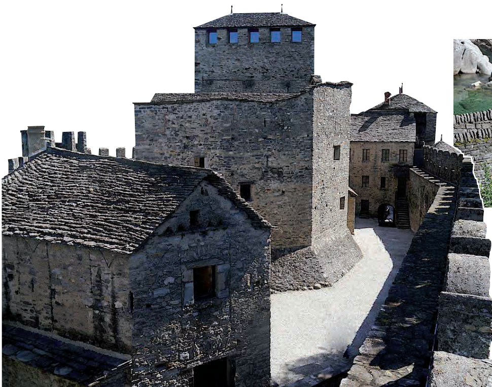
Abb. 11: Die Dächer des Castello di Montebello in Bellinzona bestehen aus Gneis. Das ist eine der drei mittelalterlichen Burgen der Stadt, die Teil des UNESCO-Weltkulturerbes sind.
