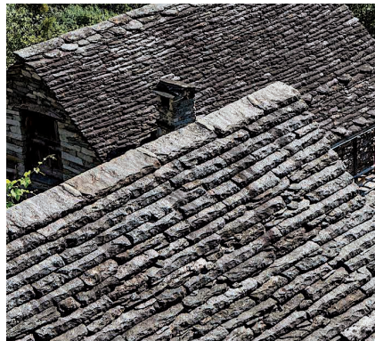
Abb. 9: Neues Dach aus Gneis
