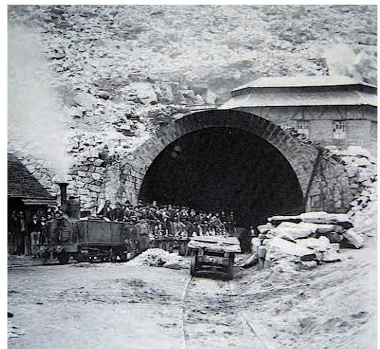
Abb. 15: Bauzug mit Arbeitern vor dem Nordportal des Gotthardtunnels, ca. 1875
