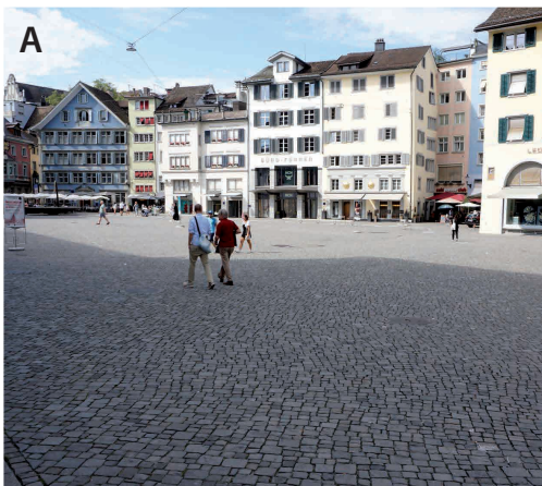
Abb. 1A, B: Pflastersteinbelag aus Guberstein auf dem Münsterhof. Die Sandsteine sind unterschiedlich grobkörnig.
