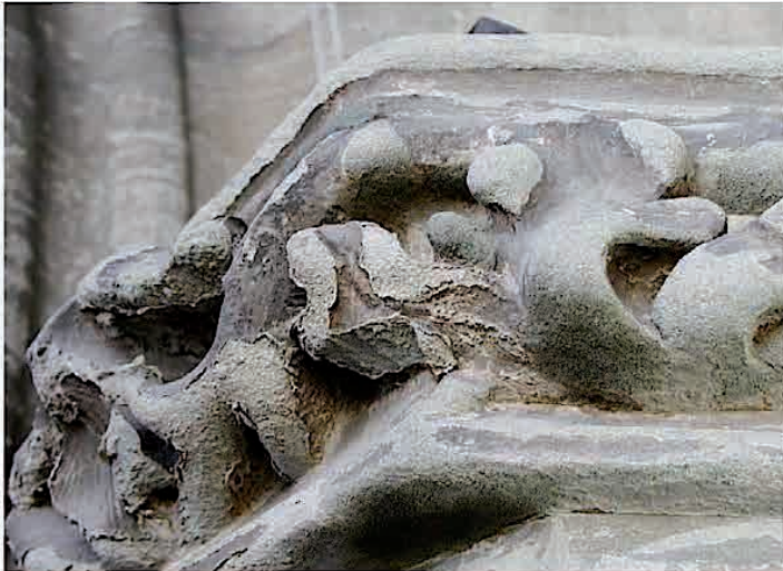
Abb. 10: In diesem Bereich des Berner Münsters war der Sandstein bereits derart stark abgeblättert, dass die ursprüngliche Form der Verzierungen kaum mehr zu erkennen war.
