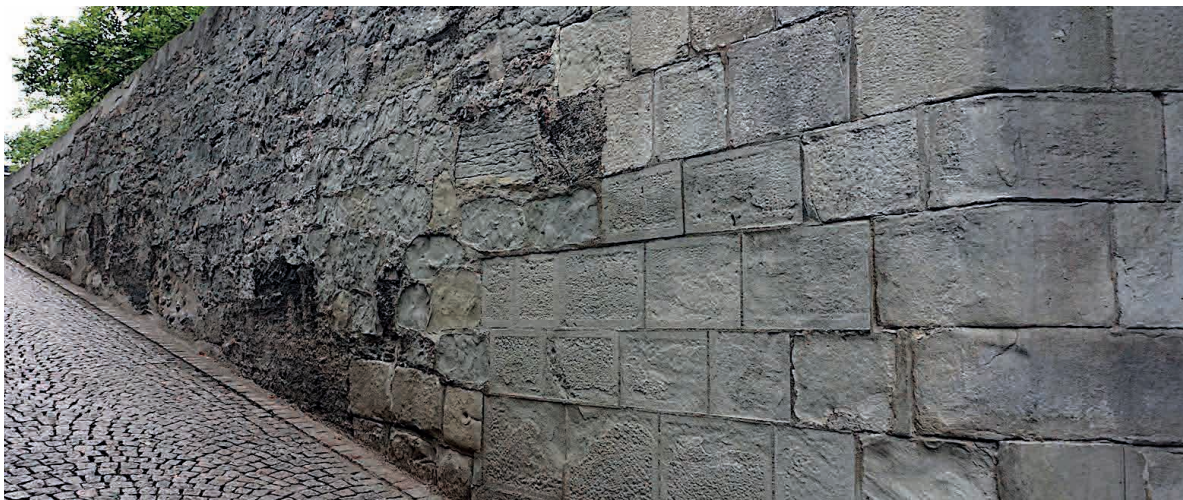
Abb. 1: Stark verwitterter Sandstein am Lindenhof und in der Fortunagasse
