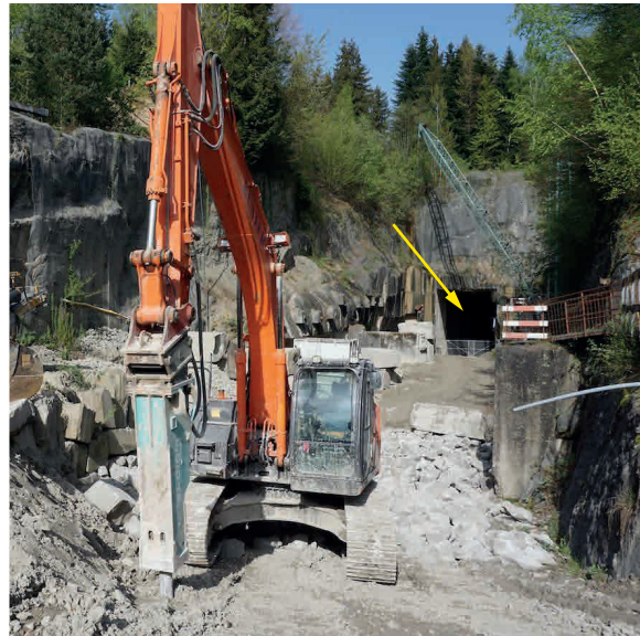
Abb. 18: Im Steinbruch Lehholz wurden die Schächte mit minderwertigem Ausbruchmaterial aufgefüllt und es wurde auf den Abbau in einer Kaverne (Pfeil) umgestellt. Diese wird über 100 m lang werden.
