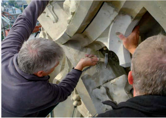
Abb. 15: Ein neu hergestellter Stein wird anstelle eines kaputten Steins eingesetzt.
