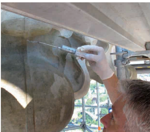
Abb. 12: Injektion einer Flüssigkeit, die in den Rissen aushärtet und den beschädigten Stein stabilisiert. Dafür wird eine medizinische Spritze verwendet.
