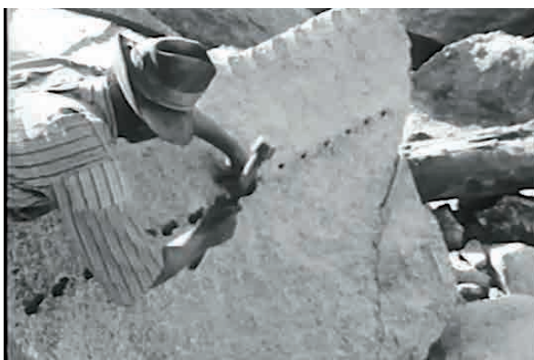
Abb. 17: Die Granitblöcke wurden von Hand mit Hammer und Keilen gespalten
