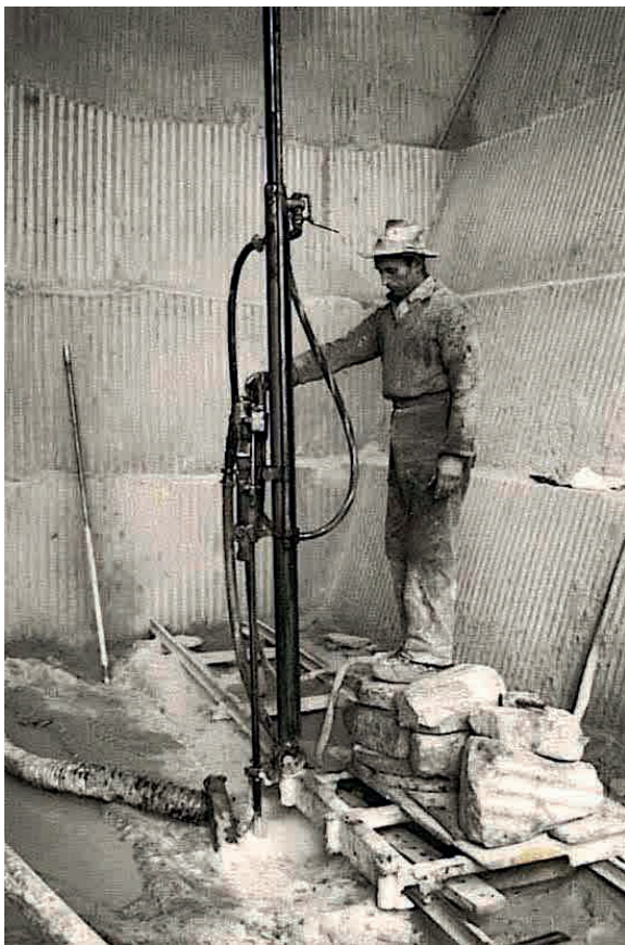
Abb. 9: Druckluftbohrmaschine, Spuren der Bohrlöcher am Fels, undatiert (zvg. Müller Natursteine AG)
