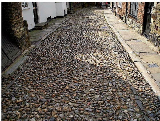
Abb. 2: So wie in diesem Dorf in England könnten die Strassen Zürichs im 15. Jh. ausgesehen haben. Der Strassenbelag besteht aus gerundeten Fluss- oder Strandgeröllen.
