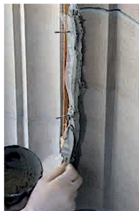
Abb. 13: Reparatur einer abgeblätterten Stelle durch das Auftragen von Spezialmörtel und feinen Netzen.
