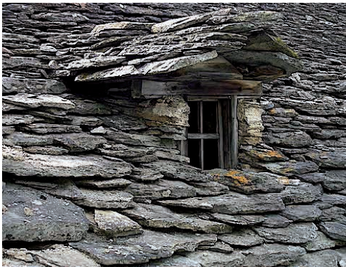
Abb. 8: Altes Dach aus Gneis
