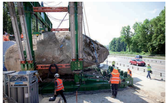
Abb. 11: Verschiebung eines 373 Tonnen schweren Findlings an der Autobahn Bern-Thun. Wenn heutzutage beim Bau einer Strasse ein Findling zum Vorschein kommt, wird er nicht etwa weggesprengt, sondern vorsichtig verschoben, da Findlinge als geschützte Steindenkmäler gelten.
