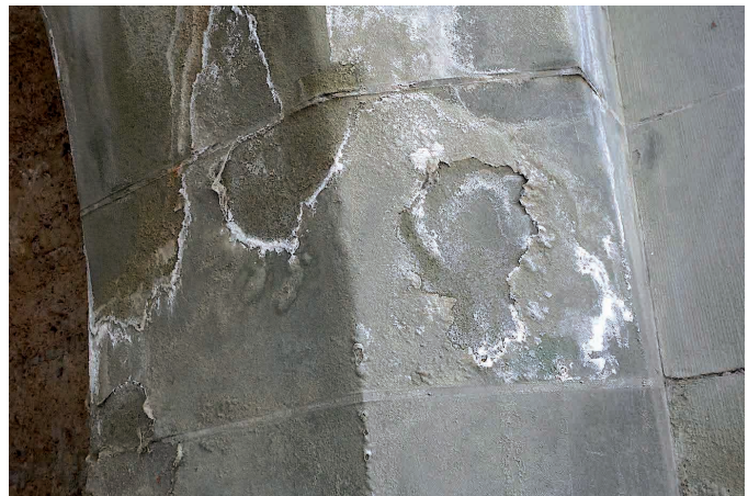
Abb. 9: Bei Feuchtigkeit wachsen in den Poren des Sandsteins feine Gipskristalle (weiss), die Schicht um Schicht des Gesteins abblättern lassen (Nydegghof, Bern).
