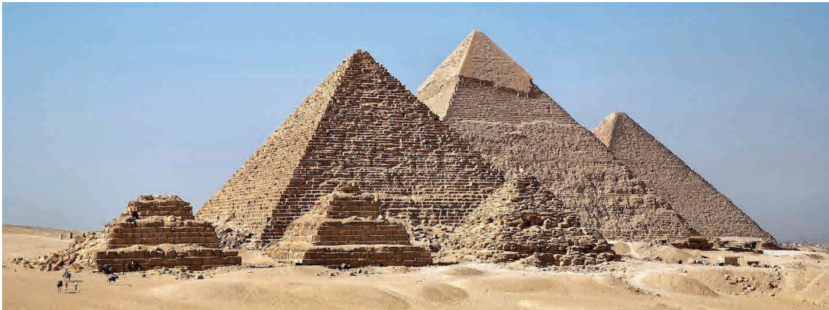
Abb. 6: Pyramiden von Gizeh in Ägypten; ein Rest der ursprünglichen Aussenhaut aus Aussuan-Granit ist noch an der Spitze der Chefred-Pyramide übrig geblieben. Das Innere der Pyramiden besteht aus weichem Kalkstein (Foto Ricardo Liberato).
