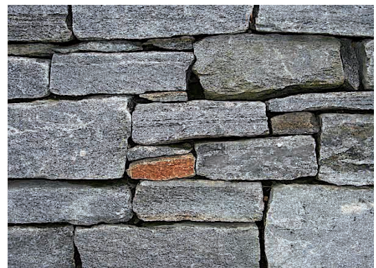
Abb. 5: Mauer aus Gneis ohne Zement (Trockenmauer)
