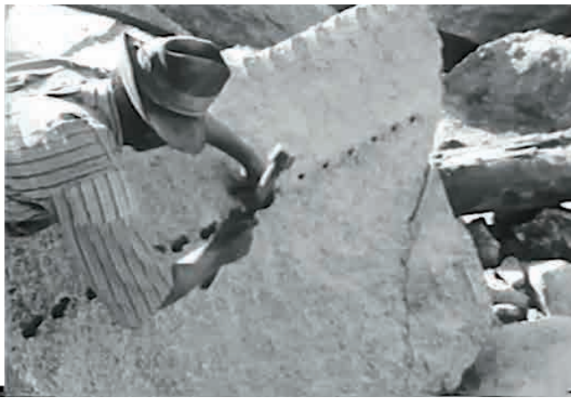
Abb. 5: Die Granitblöcke wurden von Hand mit Hammer und Keilen gespalten.
