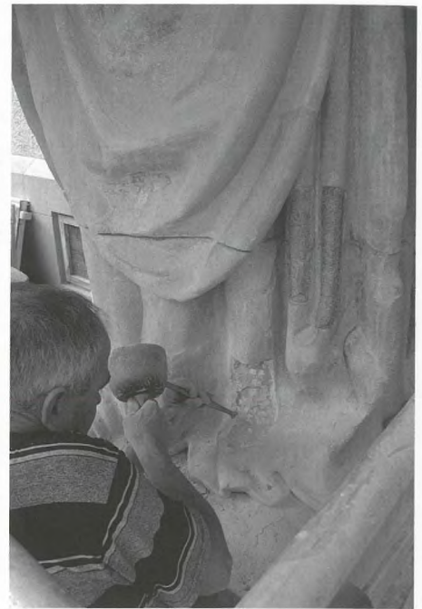
Ausbessern einer Schadstelle am hl. Desiderius im Innenhof. (Foto: architekten : rlc)
