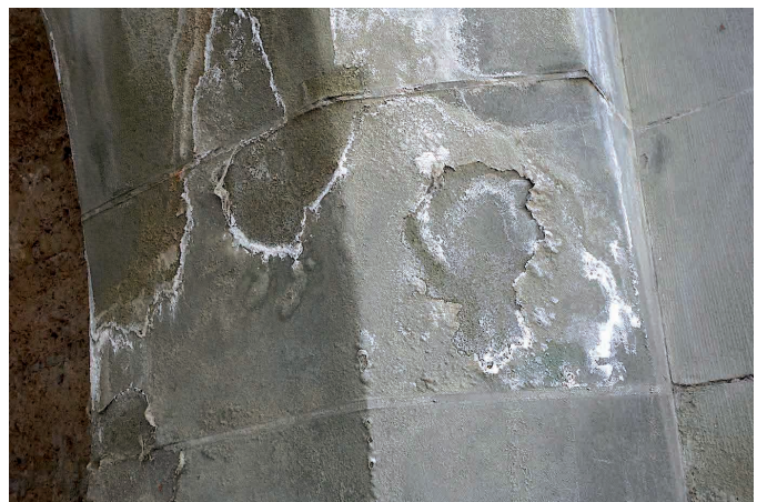
Abb. 10: Bei Feuchtigkeit wachsen in den Poren des Sandsteins feine Gipskristalle (weiss), die Schicht um Schicht des Gesteins abblättern lassen (Nydegghof, Bern).
