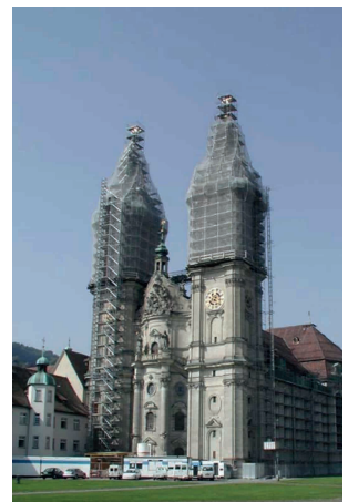
Abb. 2: Schäden vor der Renovation 2002-2003 und eingestützte Stiftskirche
