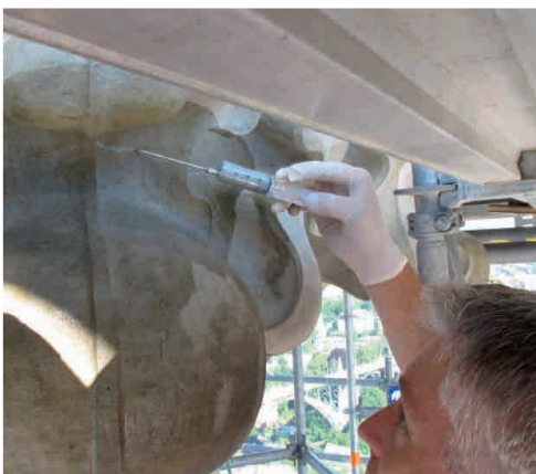
Abb. 13: Injektion einer Flüssigkeit, die in den Rissen aushärtet und den beschädigten Stein stabilisiert. Dafür wird eine medizinische Spritze verwendet.
