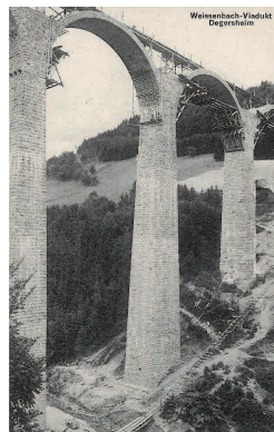
Abb. 17: Weissenbachviadukt, 64 m hoch und 282 m lang, aus «Appenzeller Granit», heute und im Bau um 1905 (J. Fritz, Schweiz. Sozialarchiv).
