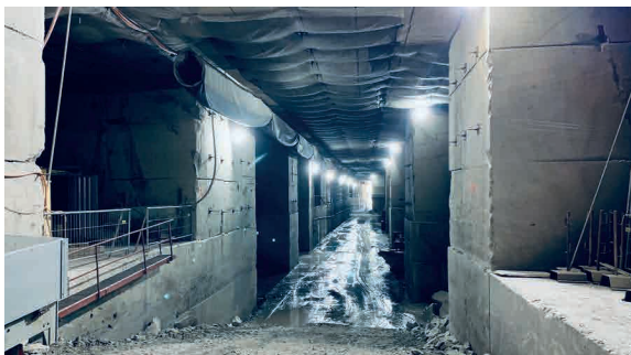
Abb. 9: Unterirdische Kaverne im Steinbruch Leholz bei Bollingen (SG). Vom Hauptgang aus werden auch seitliche Nischen abgebaut (Markus Arnitz, Linth24 ).
