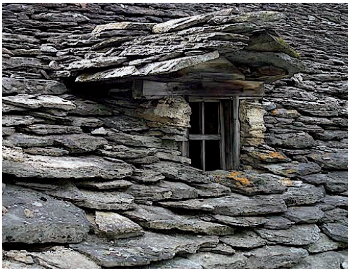
Abb. 8: Altes Dach aus Gneis
