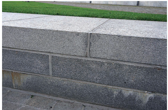
Abb. 1: Begrenzungsmauer des Klosterhofs zur Gallusstrasse hin, errichtet aus grossen Gneisblöcken.
