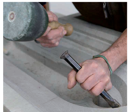
Abb. 15: Herstellung eines neuen Steins als Ersatz durch einen Steinmetz mit traditionellem Werkzeug.
