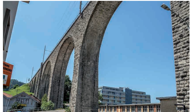
Abb. 16: Glatttalviadukt in Herisau, 34 m hoch und 296 m lang, aus «Appenzeller Granit».
