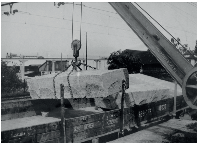
Abb. 6: Abbau mittels Bohrmaschine (auf Schienen, damit die Bohrlöcher genau in eine Linie zu liegen kommen) und Kran im Steinbruch Chreienwald; Transport der Steine mit Lastwagen und Eisenbahn (undatierte Fotos Archiv Bärlocher AG)
