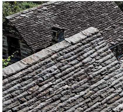
Abb. 9: Neues Dach aus Gneis
