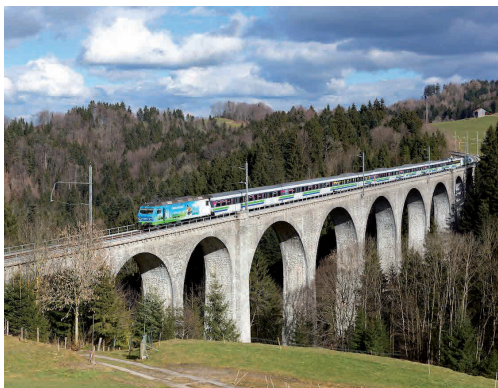
Abb. 17: Weissenbachviadukt, 64 m hoch und 282 m lang, aus «Appenzeller Granit», heute und im Bau um 1905 (J. Fritz, Schweiz. Sozialarchiv).
