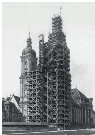
Abb. 1: Schäden vor der Renovation 1928-38 (Pfeil) und eingestützte Stiftskirche
