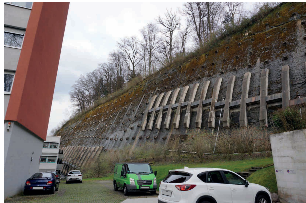
Abb. 19: Der ehemalige Steinbruch an der Sagenmattstrasse ist mit einem Gitter aus Betonrippen und Felsankern gesichert.
