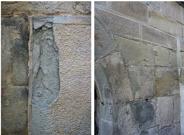
Abb. 8: Diverse Stellen mit abblätterndem «Luzerner Sandstein» am Haus Bahnhofstrasse 16. Den Grund für das Abblättern kann man hier von aussen nicht sehen.
