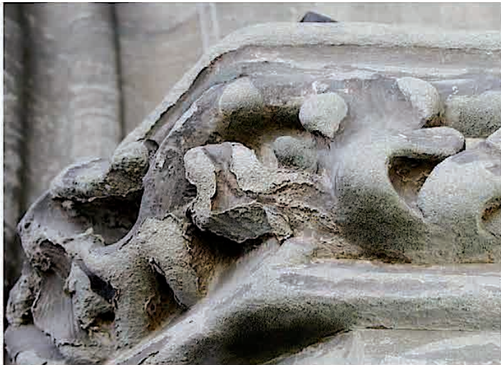
Abb. 10: In diesem Bereich des Berner Münsters ist der Sandstein bereits so stark abgeblättert, dass die ursprüngliche Form der Verzierungen kaum mehr zu erkennen ist.
