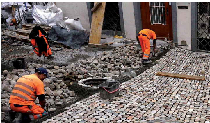
Abb. 3: In der Altstadt von Basel wird die Tradition der Hälblinge noch immer gepflegt, sie werden dort «Gwäggi» genannt. Damit der Strassenbelag den heutigen Bedürfnissen genügt und auch behindertengerecht ist, werden die Flussgerölle in der Mitte zersägt statt mit dem Hammer halbiert und nach dem Verlegen noch flach geschliffen.
