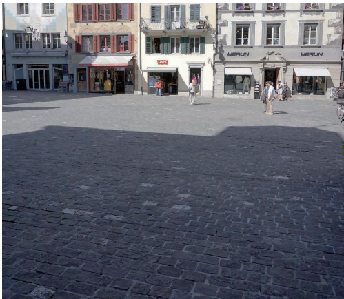
Abb. 1: Pflastersteinbelag aus Guberstein auf dem Kornmarkt. Die Sandsteine sind unterschiedlich grobkörnig.
