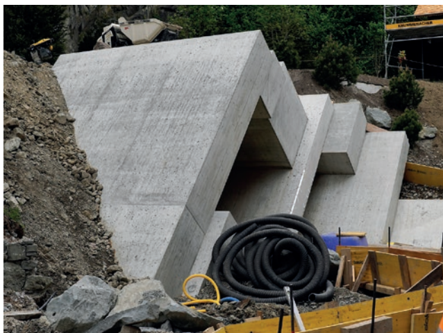
Bild 6: Die Betonbauten im Portalbereich des Besucherganges übernehmen die Geometrie der gegen NNW einfallenden Schichtflächen.
