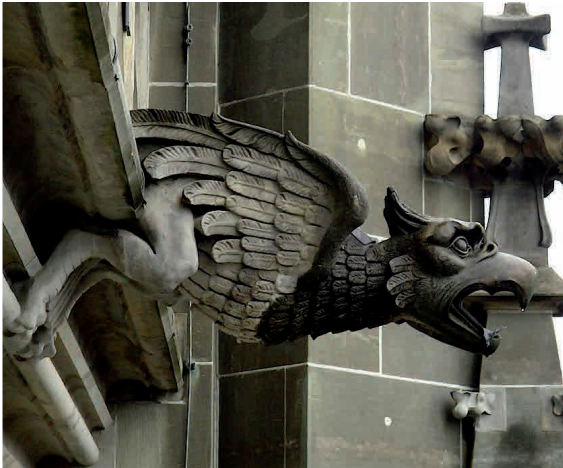
Abb. 3: Detailgenau aus dem Sandstein gehauene Figuren wie dieser Wasserspeier (zur Ableitung des Regenwassers) in Form eines Adlers verdeutlichen, wie hervorragend Molassesandstein für feinste Bildhauerarbeiten geeignet ist (Berner Münster).
