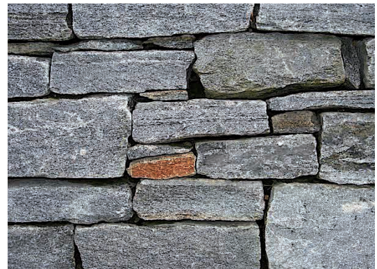
Abb. 5: Mauer aus Gneis ohne Zement (Trockenmauer)
