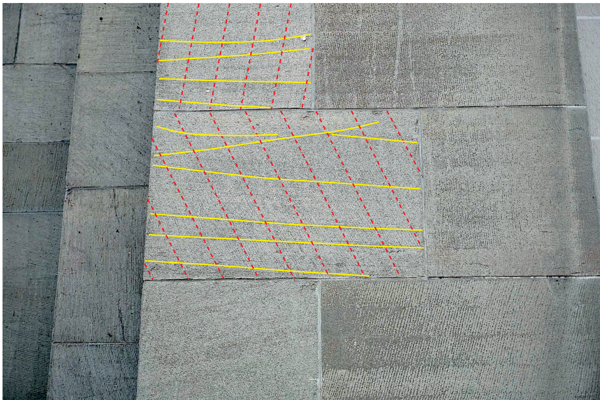
Abb. 3: Schichtung im Gestein (gelb) und oberflächliche Bearbeitungsspuren (Scharrierung, rot)
