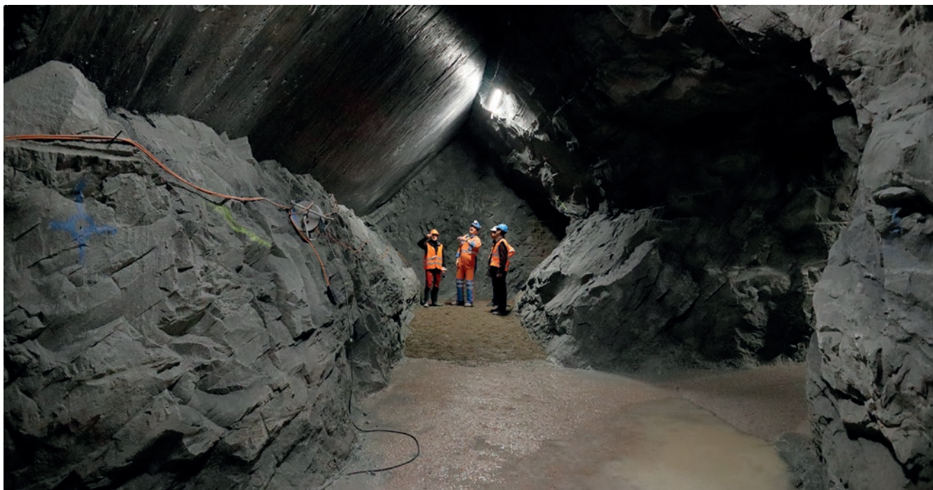
Bild 1: Die spezielle Geometrie des Besucherschachtes ergibt sich aus dem Vortrieb entlang der Schicht- und den senkrecht dazu stehenden Klüftflächen.
