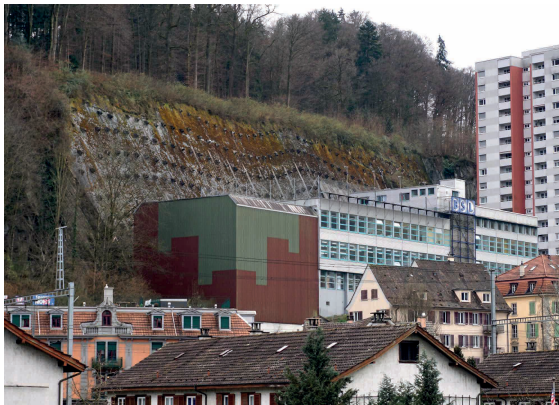
Abb. 19: Der ehemalige Steinbruch an der Sagenmattstrasse ist mit einem Gitter aus Betonrippen und Felsankern gesichert.
