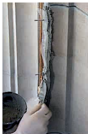
Abb. 21: Reparatur einer abgeblätterten Stelle durch das Auftragen von Spezialmörtel
