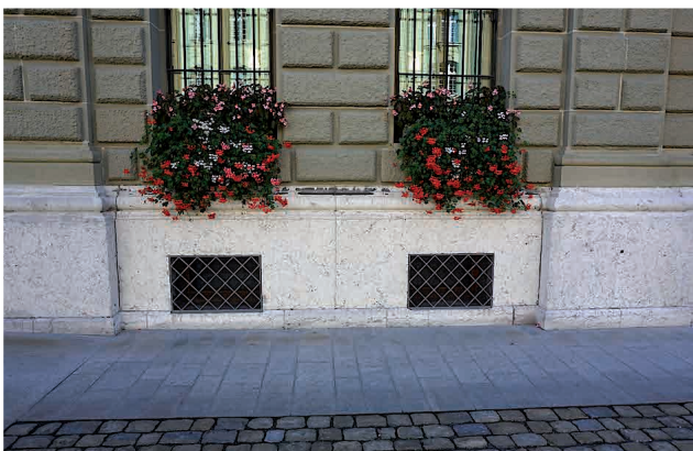
Abb. 7: Sockel aus Solothurner Kalkstein unten und Fassade aus Berner Sandstein (siehe Posten 5) oben am Bundeshaus Ost
