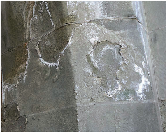
Abb. 17: Bei Feuchtigkeit wachsen in den Poren des Sandsteins feine Gipskristalle (weiss), welche Schicht um Schicht des Gesteins abblättern lassen (Nydegghof).
