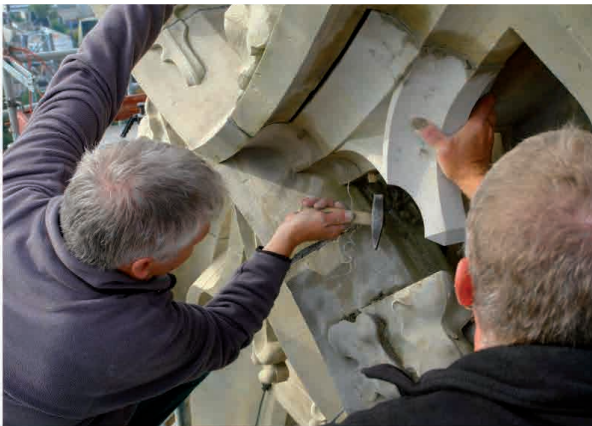
Abb. 23: Ein neu hergestellter Stein wird anstelle eines kaputten Steins eingesetzt.
