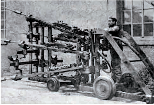
Abb. 16: Beim Bau des Gotthard-Eisenbahntunnels wurden druckluftbetriebene Mehrfach-Bohrmaschinen eingesetzt. Damit konnten gleichzeitig sechs bis 1 Meter tiefe Sprenglöcher gebohrt werden.
