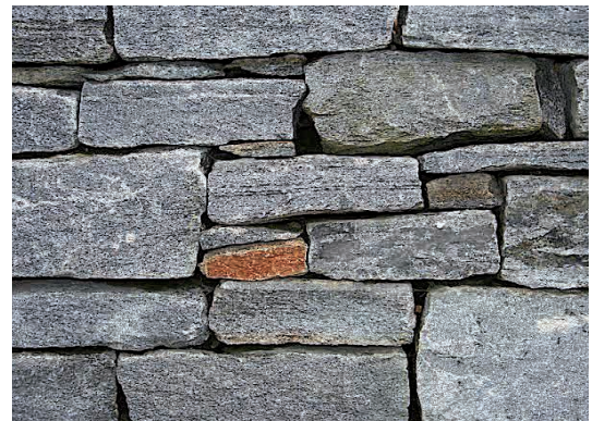
Abb. 5: Mauer aus Gneis ohne Zement (Trockenmauer)
