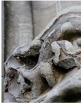
Abb. 18: In diesem Bereich des Münsters war das Gestein bereits sehr stark abgeblättert, sodass die ursprüngliche Form der Verzierungen kaum mehr zu erkennen war.
