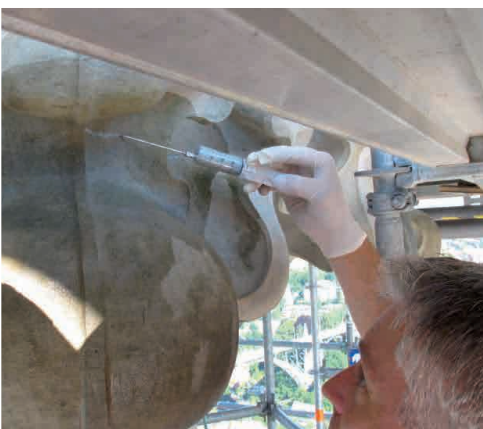
Abb. 20: Injektion einer Flüssigkeit, welche in den Rissen aushärtet und den beschädigten Stein stabilisiert. Dafür wird eine medizinische Spritze verwendet.
