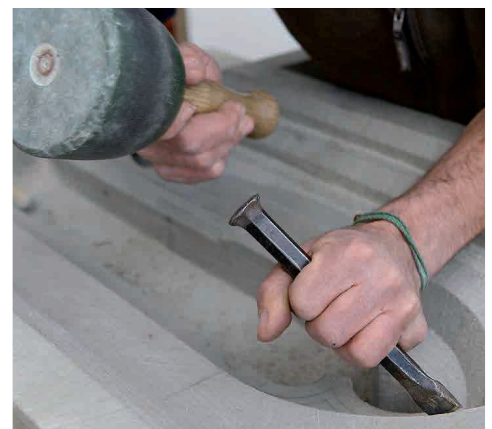
Abb. 22: Herstellung eines neuen Steins als Ersatz durch einen Steinmetz mit traditionellem Werkzeug.
