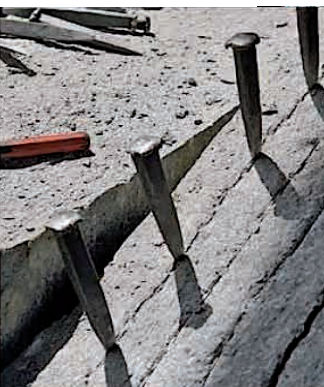
Abb. 3: Spalten von Gneis zu Platten
