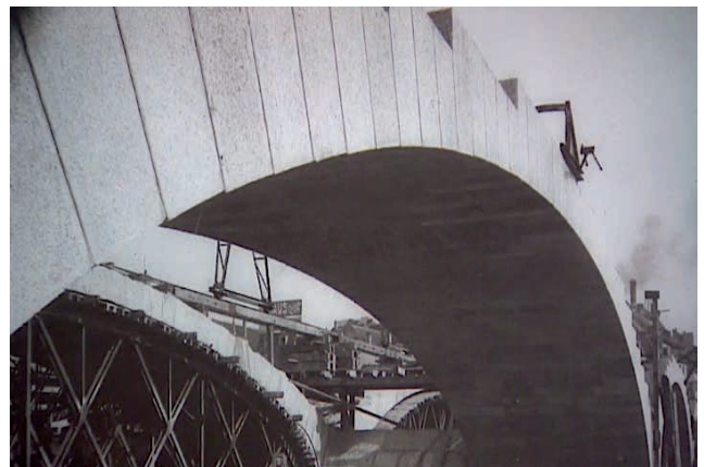
Abb. 10: Bau der Bögen der Mittleren Rheinbrücke aus Granit
