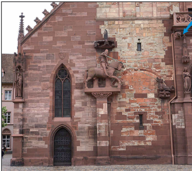
Abb. 2: Südwestfassade des Münsters unterhalb des Georgsturmes; hier wurden drei verschiedene Typen von Sandsteinen verbaut.
