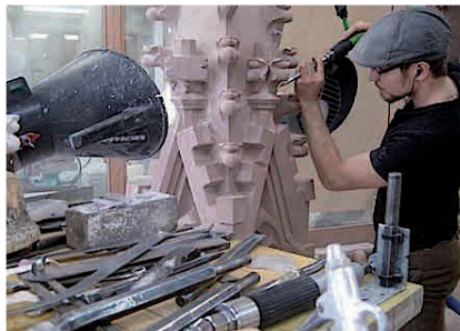
Abb. 29: Steinmetze arbeiten bei der Herstellung von Ersatzsteinen mit modernen Elektro- bzw. Pressluftwerkzeugen ...
