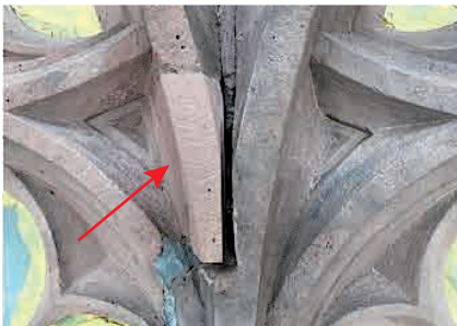
Abb. 28: Einsetzen eines neu hergestellten Ersatzsteins (Pfeil)
