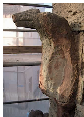
Abb. 23: Bis zur Unkenntlichkeit abgeblätterte Figur am Basler Münster
