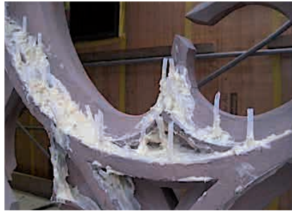
Abb. 26: Durch aufgeklebte Röhrchen wird ein flüssiger Kunststoff in Spalten gegossen, der aushärtet und den Stein von Innen stabilisiert.
