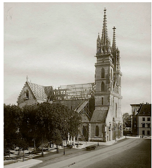
Abb. 14: Einbau des Eisendachstuhls am Münster, 1880/90; Foto Kantonale Denkmalpflege Basel-Stadt, Sammlung Münsterfoto
