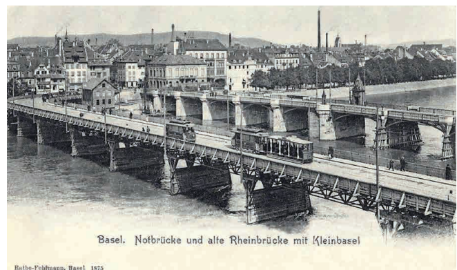
Abb. 4: Notbrücke über den Rhein während des Baus der neuen Brücke 1903-1905 mit Tram. Rechts die alte Brücke vor dem Abriss.
