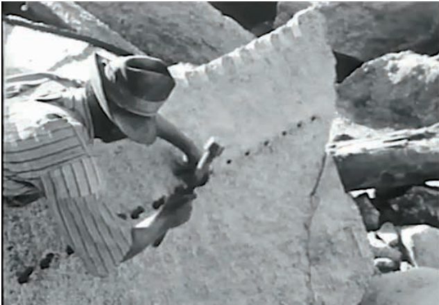
Abb. 7: Die Granitblöcke wurden von Hand mit Hammer und Keilen gespalten.
