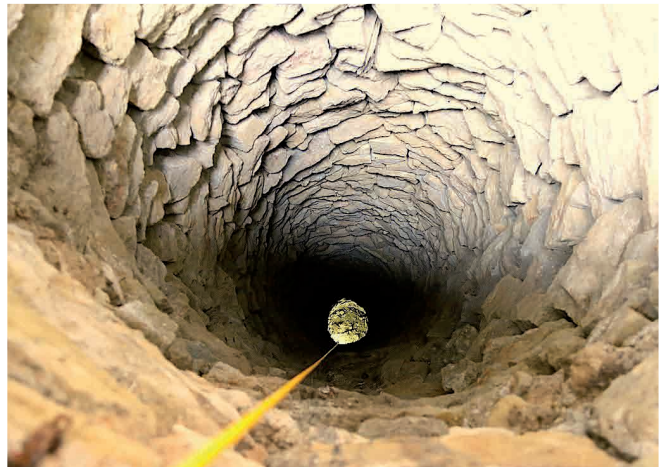
Abb. 8: Bevor er durch die Bautätigkeit späterer Jahrhunderte teilweise zerstört wurde, könnte der römische Sodbrunnen vom Münsterhof ähnlich ausgesehen haben wie dieser mittelalterliche Sodbrunnen im zürcherischen Bülach, der 14.5 m tief ist. Sein Grund ist für Restaurierungsarbeiten beleuchtet.
