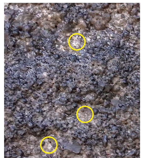
Abb. 3: Belag auf den Steinen der Martinskirche. Spuren von Hammerschlägen sind gelb markiert.
