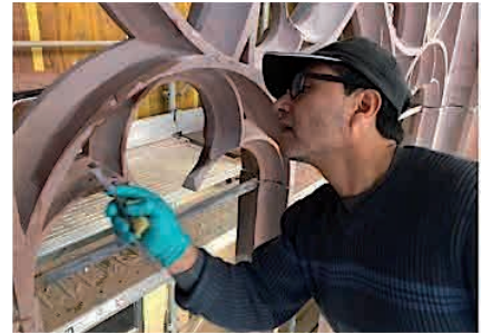
Abb. 27: Nachformen abgeblätterter Stellen mit rot gefärbtem Mörtel
