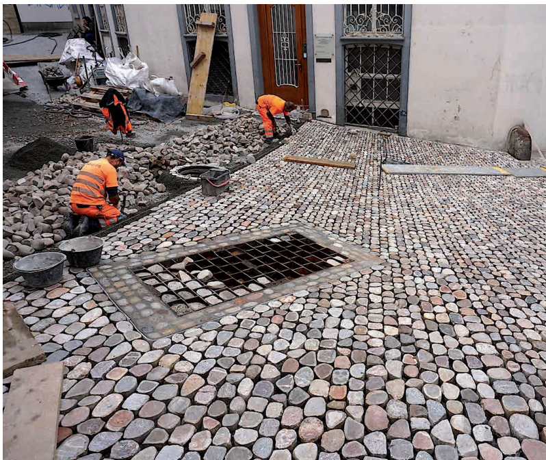
Abb. 5: Verlegen von Gwäggi am Schlüsselberg im November 2018
