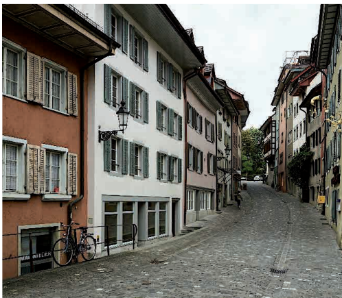
Abb. 1: Pflastersteinbelag aus Guberstein in der Unteren Halde. Die Sandsteine sind unterschiedlich grobkörnig.
