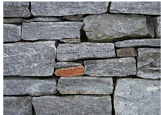
Abb. 5: Mauer aus Gneis ohne Zement (Trockenmauer)
