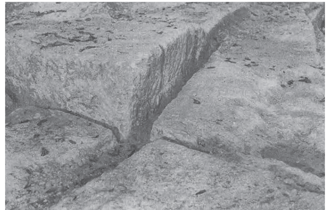
Abb. 2: Reste von Rillen im Fels zum Abbau von Quadersteinen, ca. 1937; Foto Paul Haberbosch
