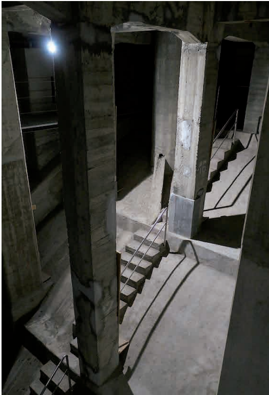
Abb. 15: Das Innere des grossen Brückenbogens ist hohl und begehbar. Dadurch kann die Brücke nicht nur von aussen, sondern auch von innen auf Risse und Verformungen überprüft werden. Auf der Abbildung sind die Oberseite des grossen Brückenbogens und einige Tragpfeiler der Fahrbahn zu sehen, die auf dem Betonbogen stehen.
