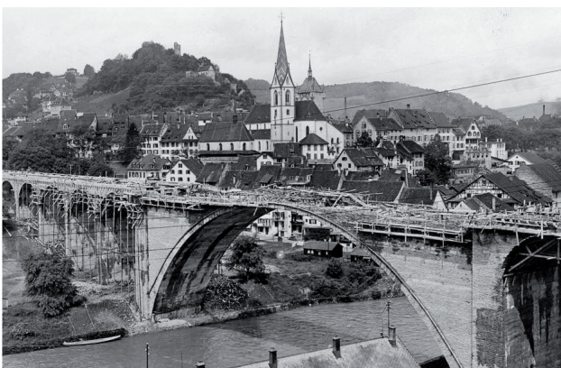
Abb. 13: Die Zwischenräume sind beinahe fertig ausgefüllt (Stadtarchiv Baden).
