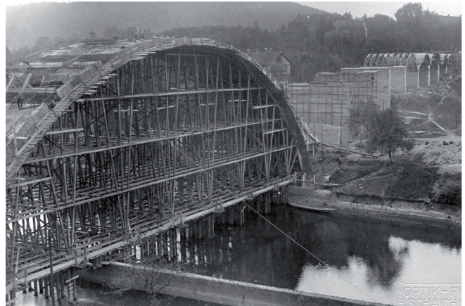
Abb. 11: Betonieren des grossen und der kleinen Brückenbogen (Stadtarchiv Baden)
