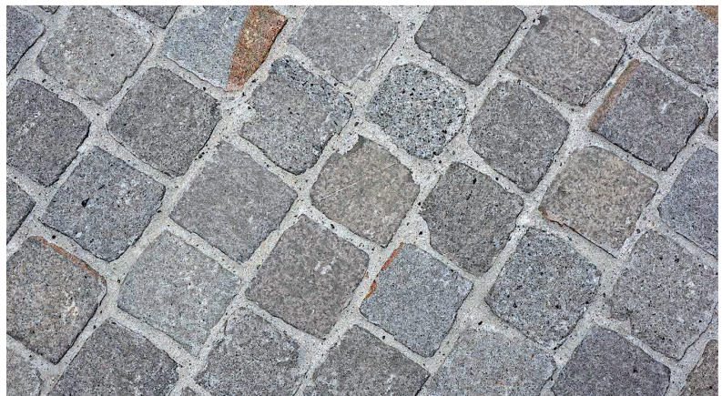
Abb. 1: Pflastersteinbelag aus Guberstein in der Unteren Halde. Die Sandsteine sind unterschiedlich grobkörnig.
