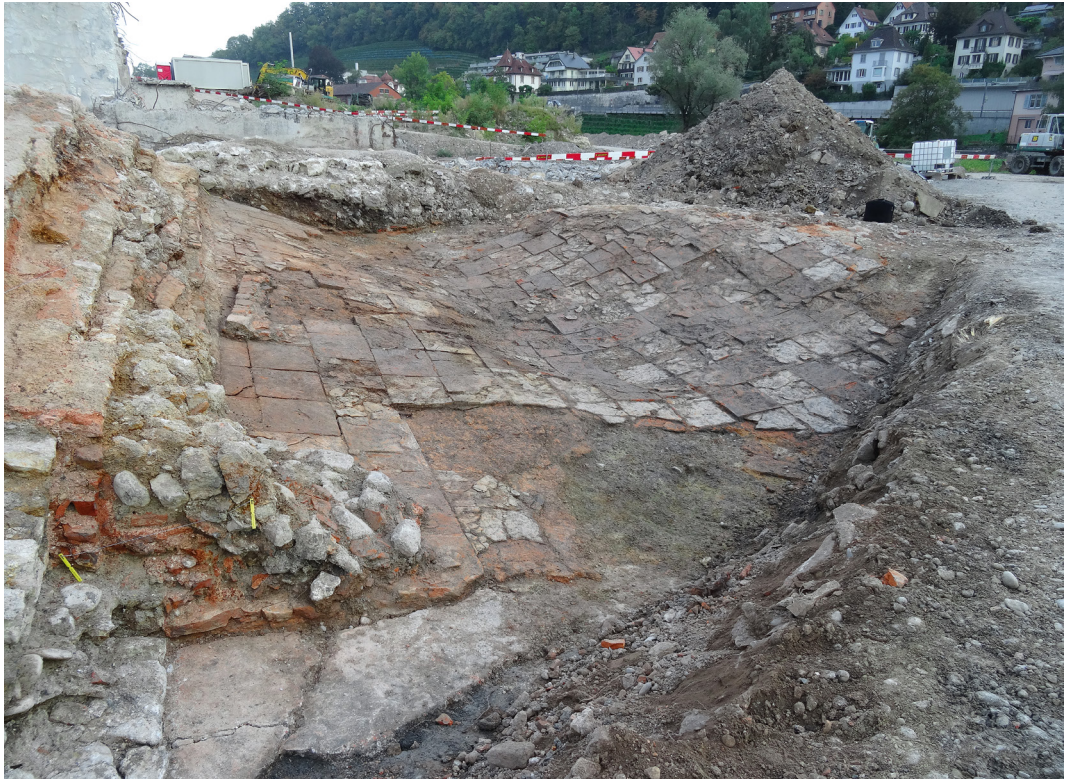
Fig. 5: Subrosions-Schaden: Absenkung eines römischen Bassinbodens in Baden durch Trichterbildung infolge von Gipskarst. Lokalität: früheres Badehotel "Staadhof". Unter den Platten war römischer Beton, darunter Keuperfels. Das Bassin wurde im 3. Jahrhundert aufgegeben.
