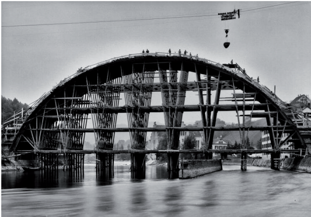
Abb. 10: Der grosse Brückenbogen wird über dem Lehrgerüst betoniert. Der Beton wird mit einer Seilbahn hin- und transportiert (Schweiz. Bauzeitung).
