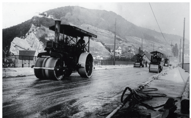
Abb. 14: Einwalzen des Fahrbahnbelags aus Asphalt mit dampfbetriebenen Walzen (Stadtarchiv Baden)
