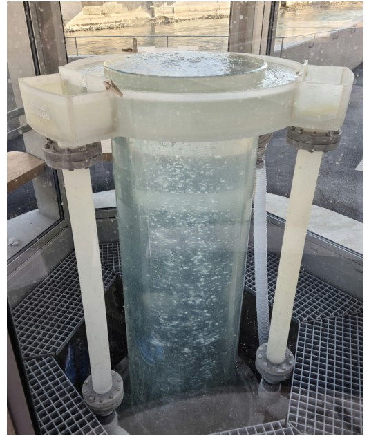
Fig. 4: Fassung der Limmatquelle; mit 150 l/min gehört sie zu den ertragreichen Thermen. Der Quellaufstieg wird mit einem transparenten Aufstiegsrohr sichtbar gemacht. Darin sieht man auch deutlich die aufsteigenden Gasblasen. Zuoberst ist kränzförmig ein Quellwasserteiler, im Hintergrund die Limmat (vgl. auch Mühlberg 1909).
