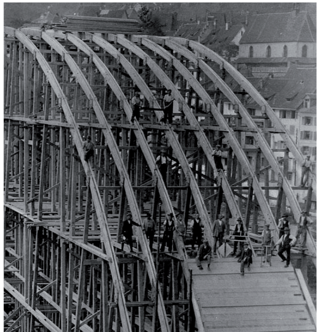
Abb. 9: Bau des hölzernen Lehrgerüsts für den grossen Brückenbogen über die Limmat; Stadtarchiv Baden
