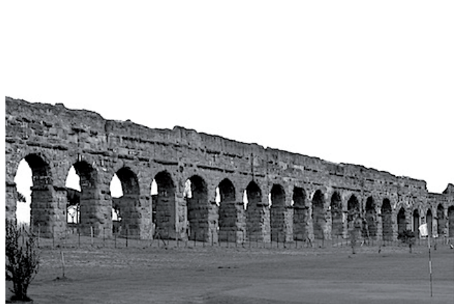
Abb. 7: Römischer Aquaedukt (Wasserleitung, die ein Tal auf einer Brücke überquert) «Aqua Claudia» bei Rom. Solche Aquaedukte dienten als Vorbild für die kleinen Bogen der Hochbrücke beidseits der Limmat.
